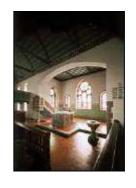
Stützen mit neugotisch geschnitzten Kopfbändern tragen die Konstruktion.
